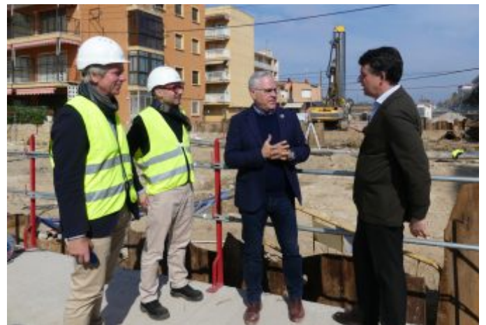
Visita d'obres al barranc de Barenys. Foto Ajuntament de Salou.
