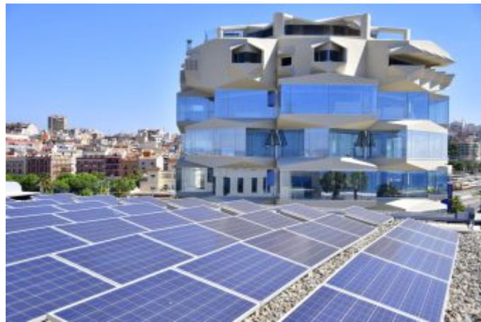
La instal·lació de panells solars a diferents espais del Port i del recinte portuari així com l'electrificació de molls i grues són iniciatives crucials. Foto cedida.
