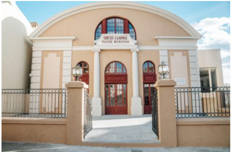
Una de las grans obres ha estat la recuperació de l'edifici de l'Orfeó Canongí. Foto cedida.
