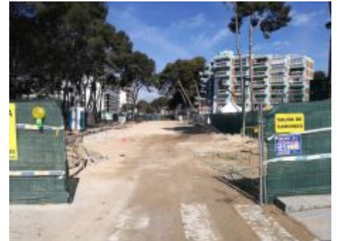
Obres a l'Av. Carles Buïgas. Foto Ajuntament de Salou.
